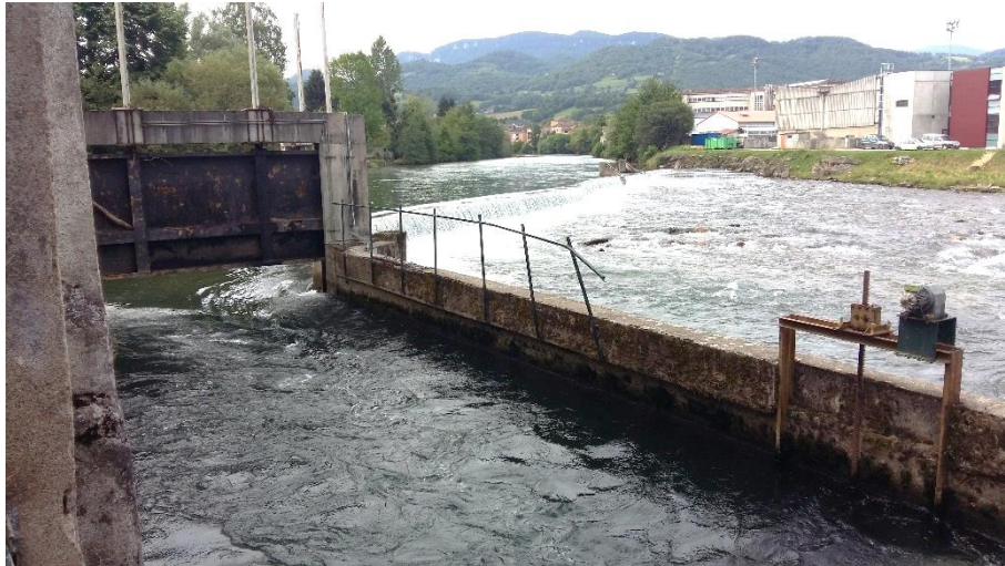
Figure 3 : Canal de prise actuel au Moulin de la Fonderie
