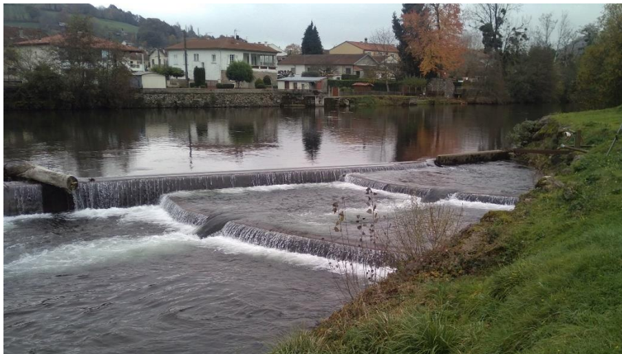
Figure 5 : Passe à poissons actuelle du Moulin de la Fonderie en rive gauche
