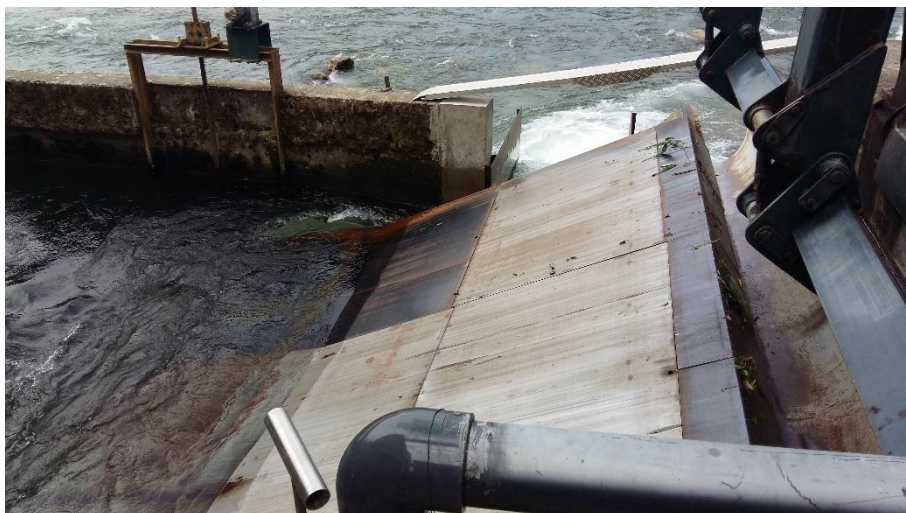
Figure 4 : Dispositif de dégrillage ichtyocompatible et goulotte de dévalaison actuelle au Moulin de la Fonderie.
